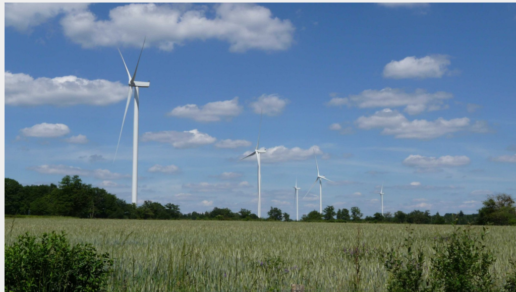
Le parc éolien de Roussac Saint-Junien-Les-Combes
