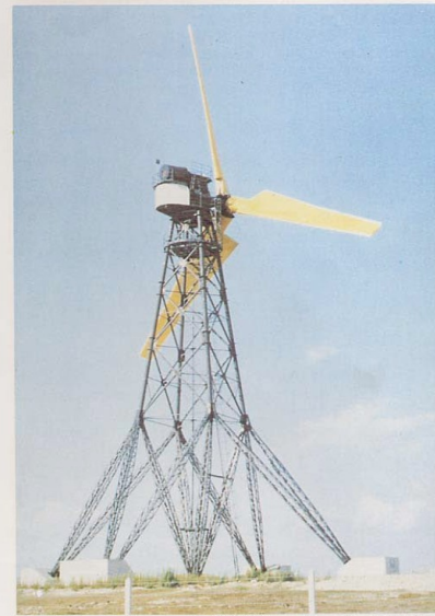
Aérogénérateur Neyrpic de 1000 kW expérimenté par EDF à Saint-Rémy-des-Landes. (Photo EDF).
